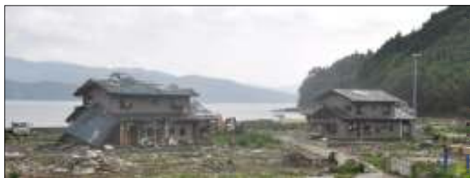
被災した石巻市・相川地区
