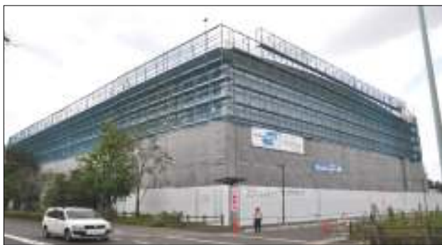
建設中の市民の森ふれあいホール（日野本町）
